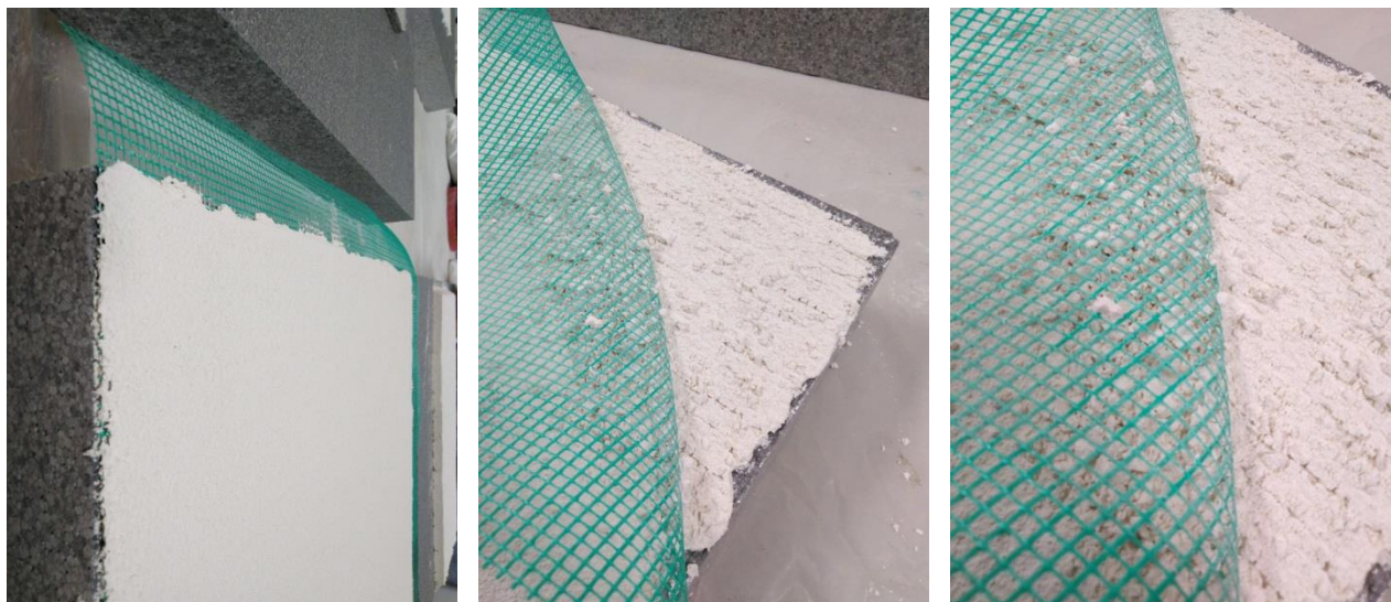
MULTICALCE – test di adesione con rete annegata
